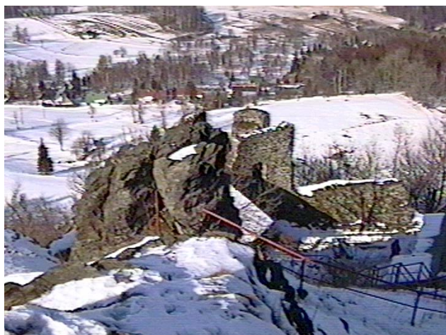
Tolštejn - věž hladomorny
