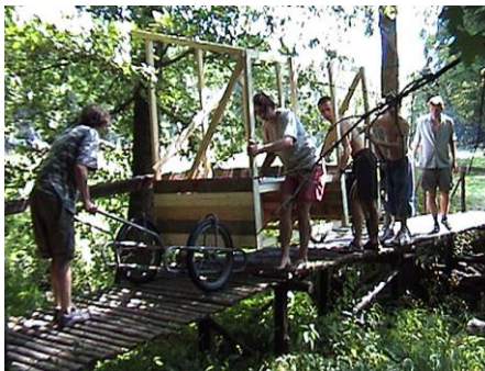
Transport první trojice kadibudek na rošt nad vykopanou jámou. Vpředu a vzadu je zasunutá kára. Na lávce bylo velice těsno, problémy dělaly i větve stromů. Během transportu došlo k malému poškození střešní konstrukce kadibudek.
