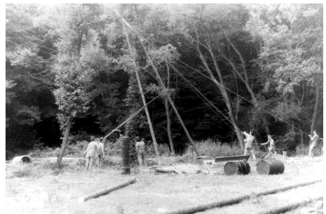
Krizový okamžik stavby vodárenské věže (1990)
