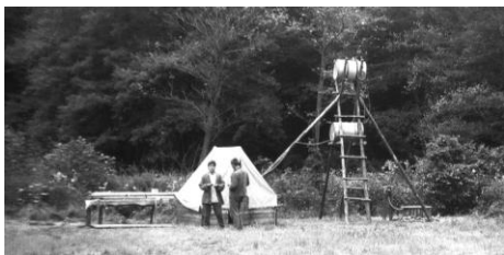
Koryto, koupelna, vodárna, pumpa, studna (1985)
