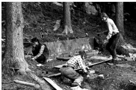
Budování základových patek srubu (1987)
