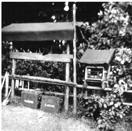
Nářadovnick v Hryzelích, malá budka vpravo obsahuje rozvod pro elektrický hlídač, dole na zemi jsou akumulátory (1973)
